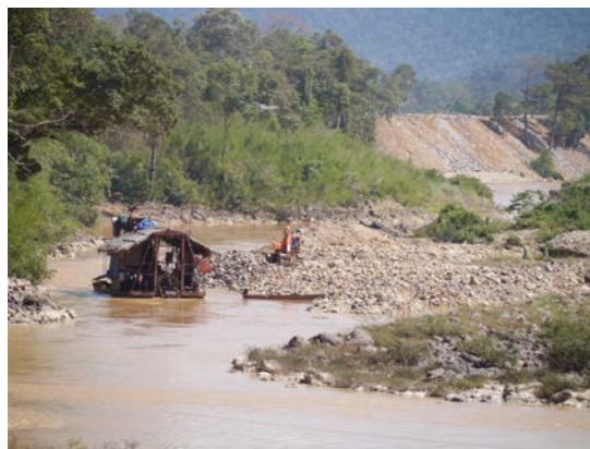
砂金の採掘船と工事の様子
