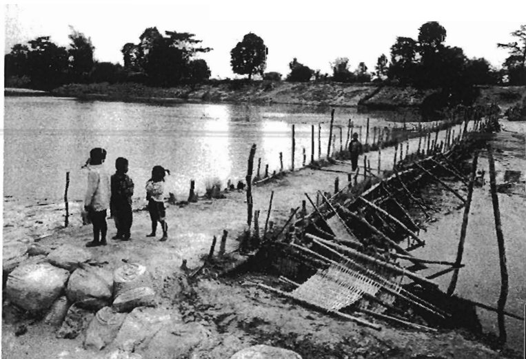
セ・バンヒヤン川流域で見られた堰。せき止められるが、下流に流す水も考えられている。(ラオス)
