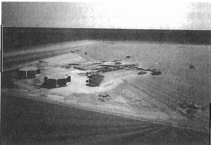
上部地で補修工事が行われていた
