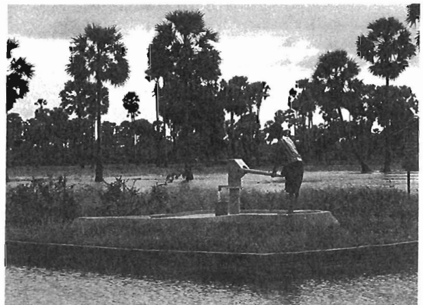
ポンプ：洪水地帯に設けられた飲料水用ポンプ
