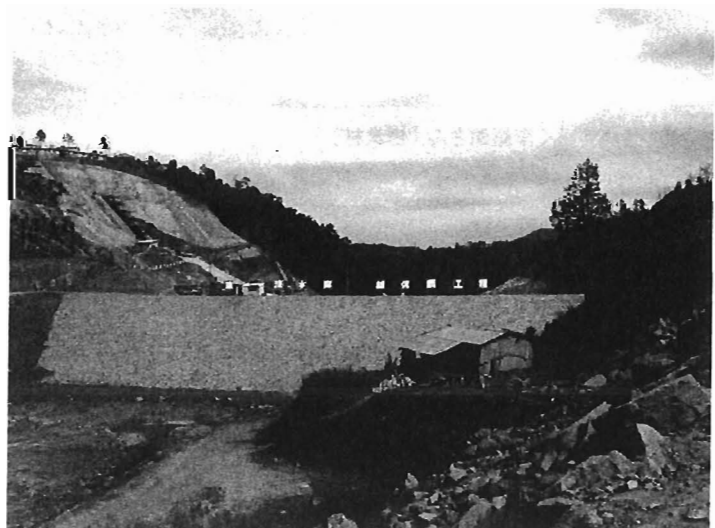
日本の ODA を使った上水道事業で建設中の雲龍ダム
