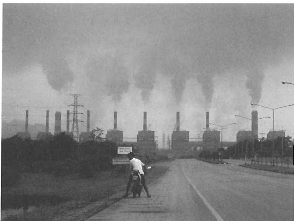
メーモ石炭火力発電所
