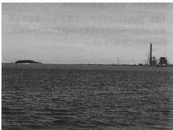
▲工事が進み、住民の不安は募る。左はサケット島(05年5月)
