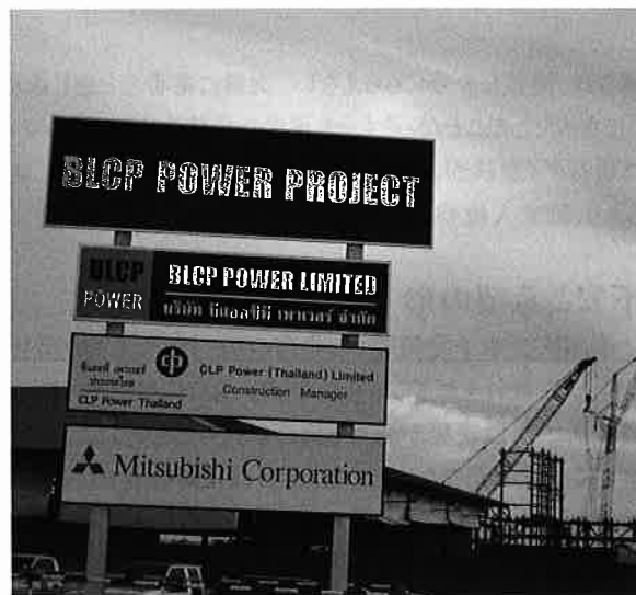
▲発電所建設現場。三菱商事の看板が見える(04年12月)
