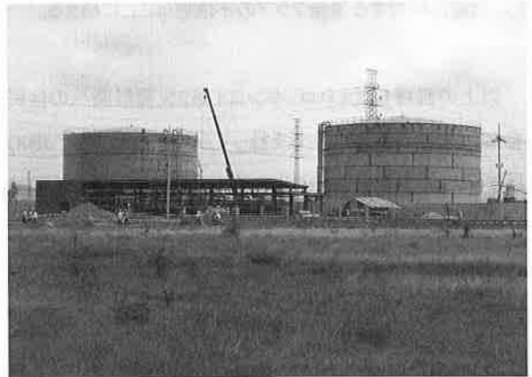
▲写真① 進行する発電所建設工事(2006年5月、撮影:メコン・ウォッチ)
