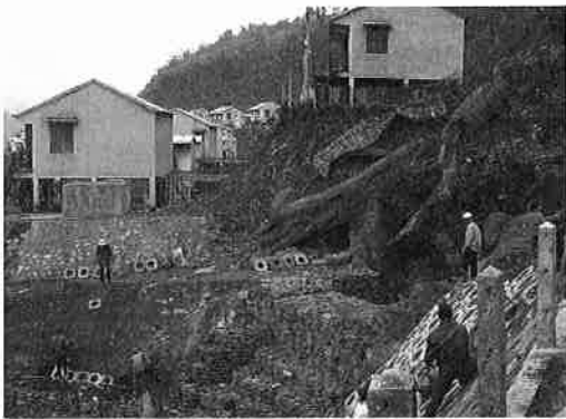
■写真3:アルア=カーラ再定住地。一部補修もされているが、未だに地滑りの危険が残る。
