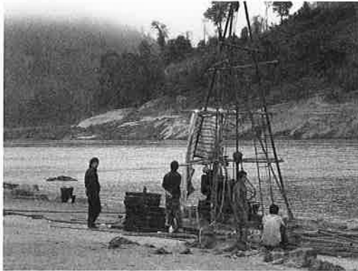
ボーリング調査の様子
