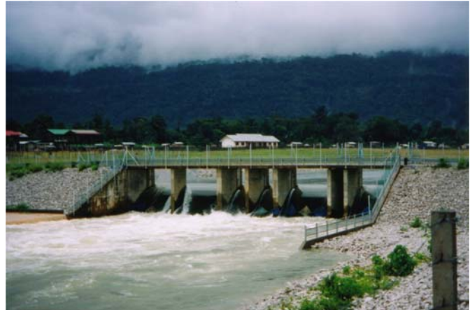
Thuen Hinboun Hydropower Project トゥンヒンブン水力発電所
