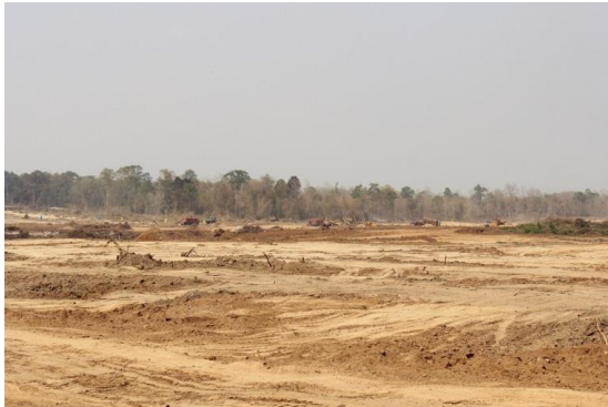
伐採が始まったセサン下流 2 水力発電所建設予定地
