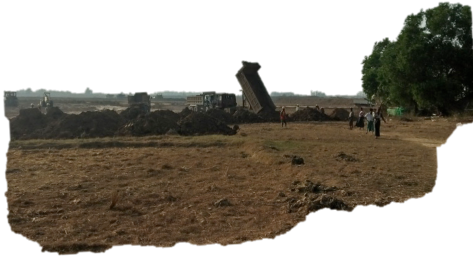
写真：工事の進む移転区域 2-2 西部（2020年2月撮影）
