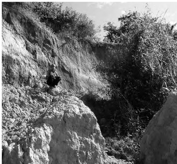
崩れ落ちた河岸 (SPN 提供)。
