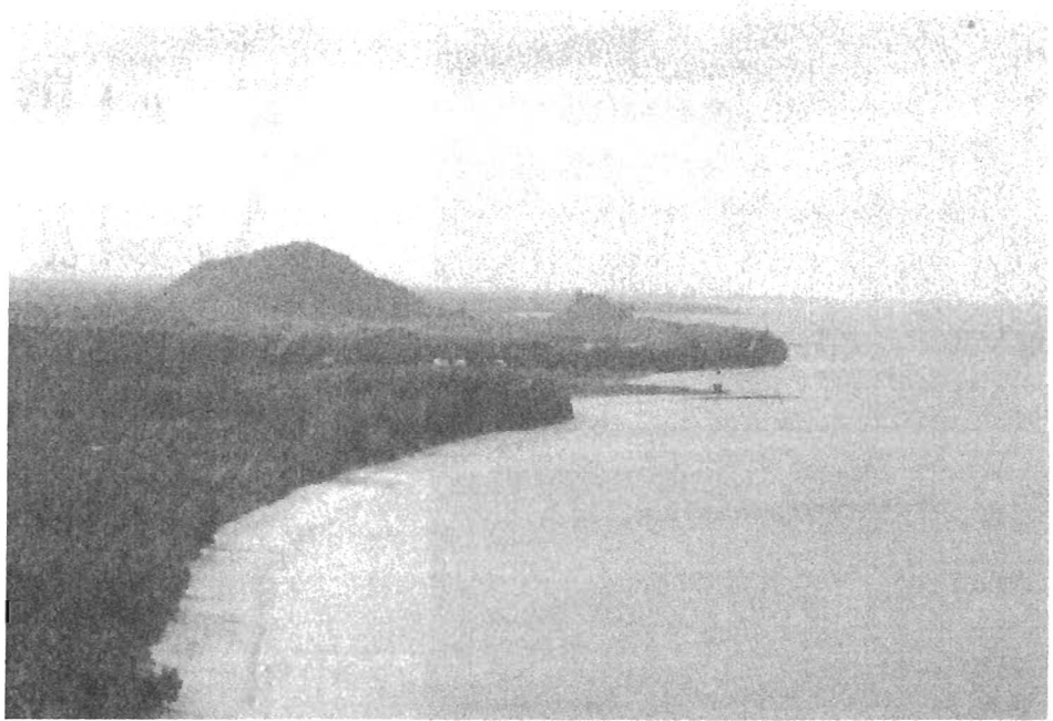
美しい砂浜が続く。森が切れているところがヒン・クルート発電所建設予定地だ。
