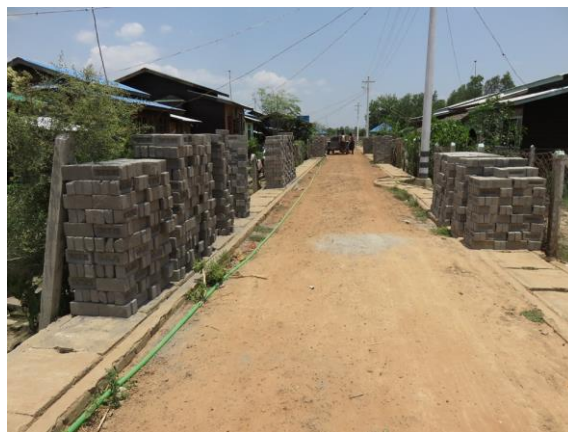
<敷居用のコンクリートが希望世帯の家前に置かれている（2015年5月）>
