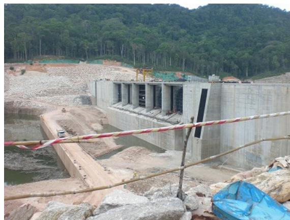
湛水が始まったばかりのダムサイトの様子
