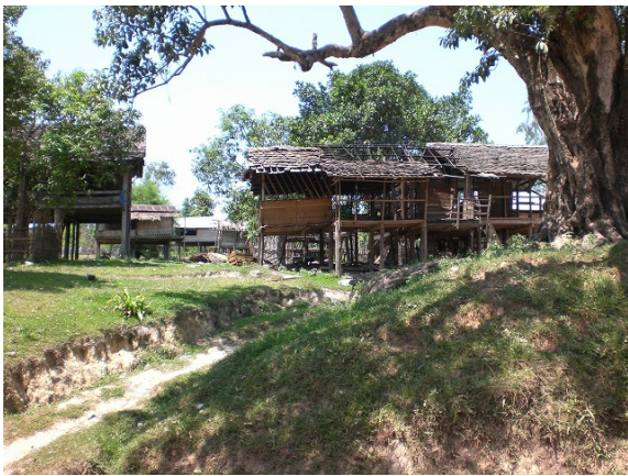
家の解体作業が進む旧ナカイヌア村
