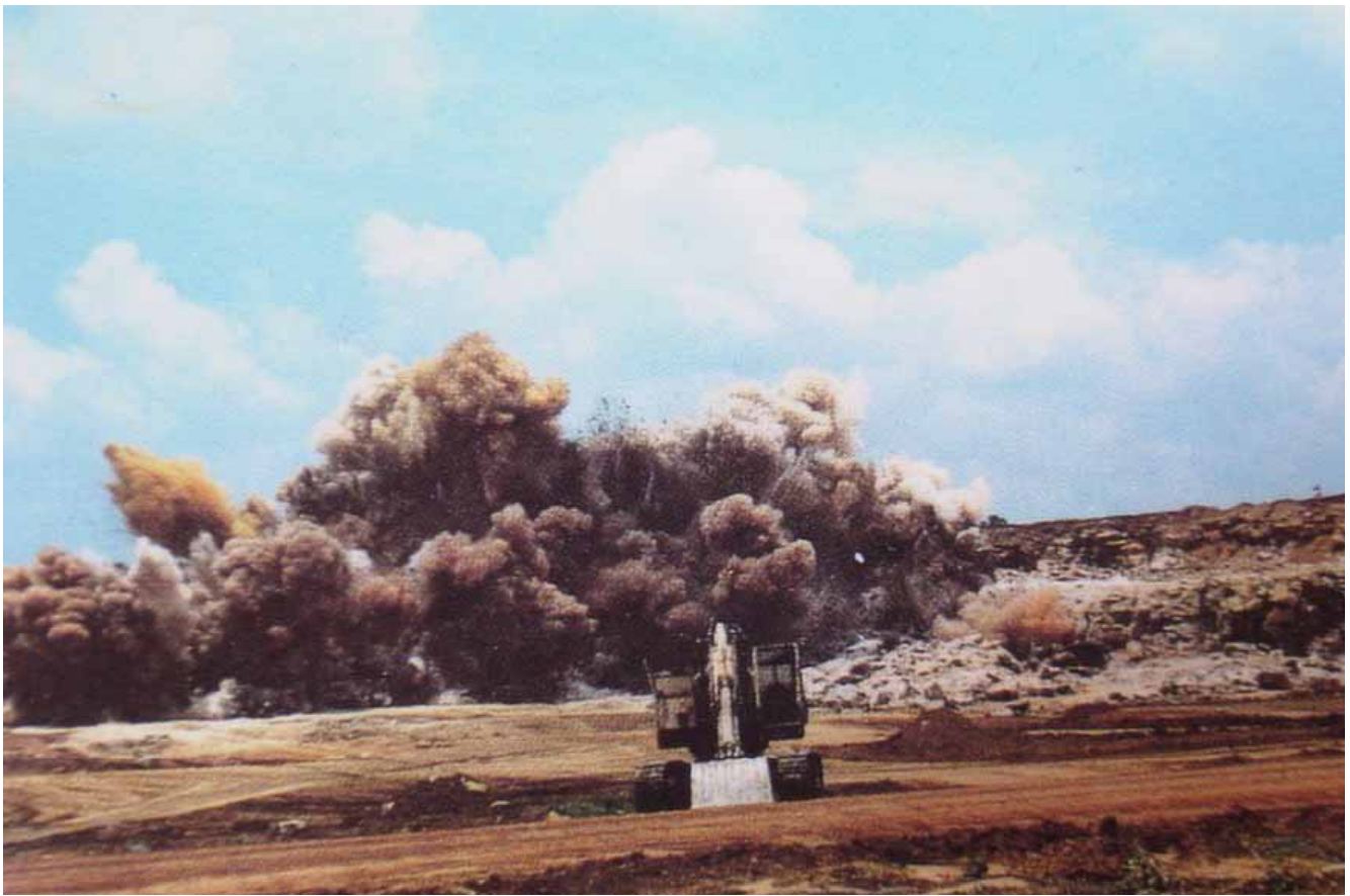
貯水池建設時の爆破作業(住民撮影)
